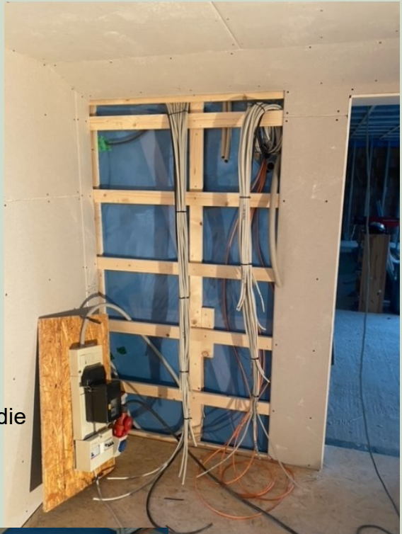
Unterkonstruktion und winddichte Verkleidung alte Hütte
