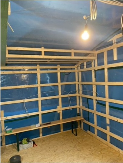
Unterkonstruktion und winddichte Verkleidung alte Hütte
